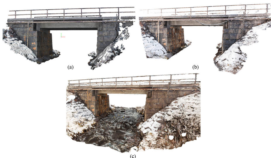
Figur 8: CRP modeller för bron över Pahtajokk: (a) Modell 1; (b) Modell 2 och (c) Modell 3.
