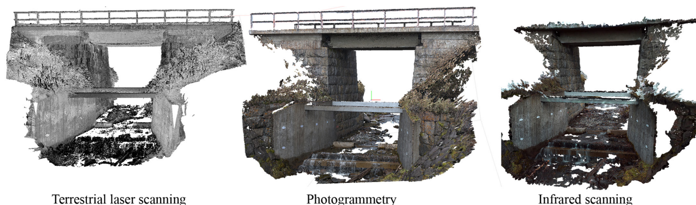
Figur 5: 3D modeller för bron över Juovajokk – Påunabäcken – skillnader i detaljnivå mellan de olika utvärderade teknologierna.
