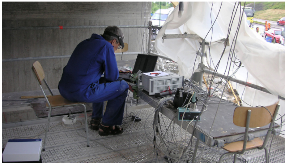
Figur 2: Mätning på bro 2006, omfattande kabeldragning.
