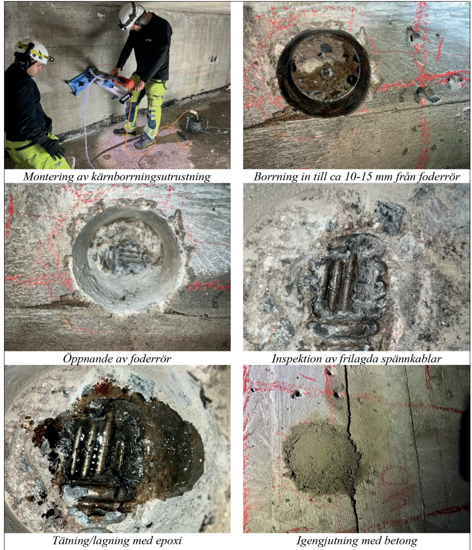
Figur 3: Borring i samband med verifiering. Normalt används en 80-100 mm kärnborr. I den högra delen visas frilagda kablar och hur det kan se ut i samband med hålrum i foderrören där fukt och syre kan komma åt.
