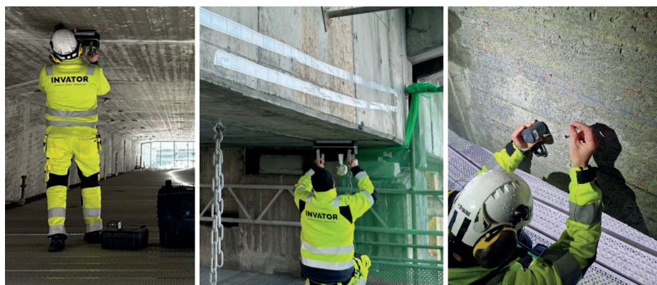
Figur 6: Undersökning med MIRA och IE.
